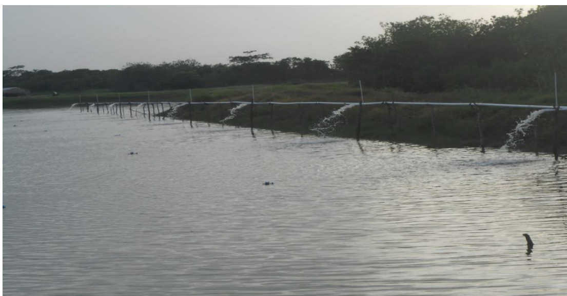
Figura A – 16. Nivelación de tubería e instalación de prototipos Venturi.
