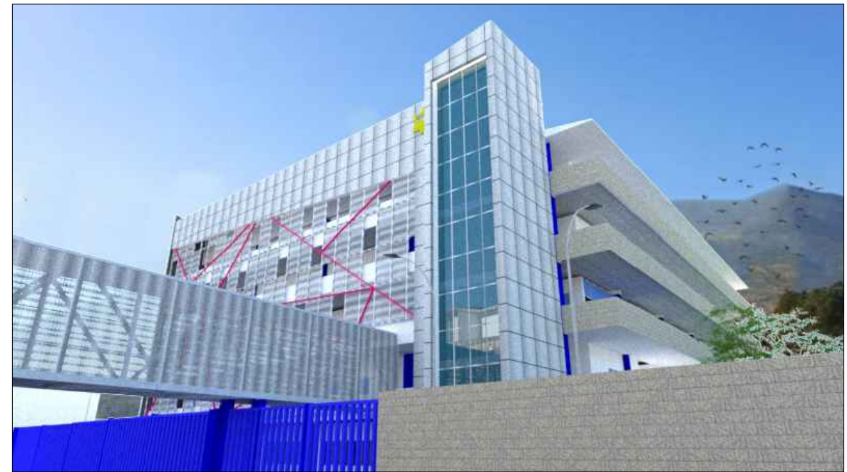
VISTA FACHADA PRINCIPAL DEL COLEGIO
