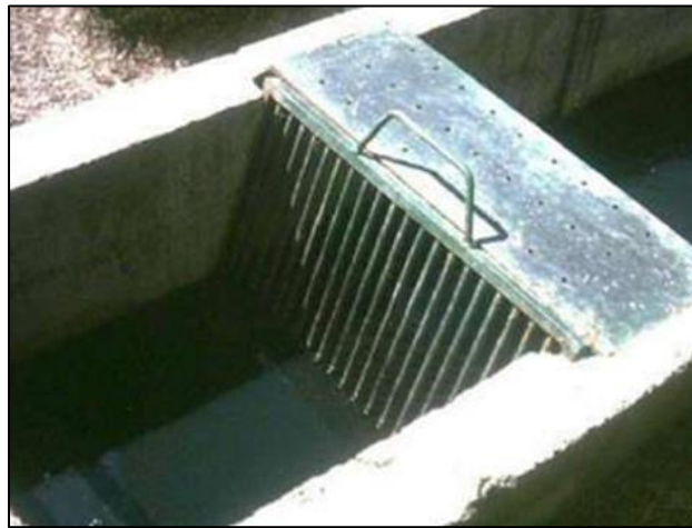
Figura 2.5 Rejillas gruesas para pretratamiento de aguas residuales
