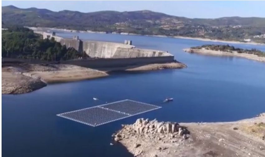
Ilustración 2: Sistema Solar Fotovoltaico flotante Montalegre
