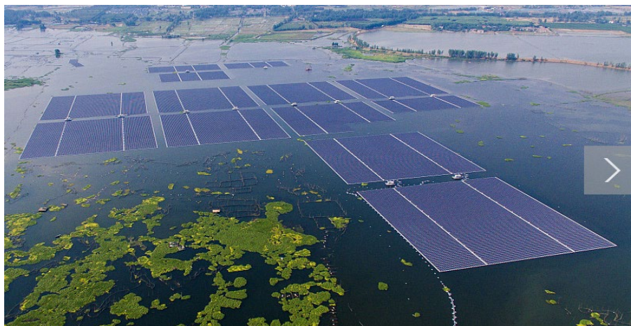
Ilustración 3: Sistema Solar Fotovoltaico flotante Anhui.
