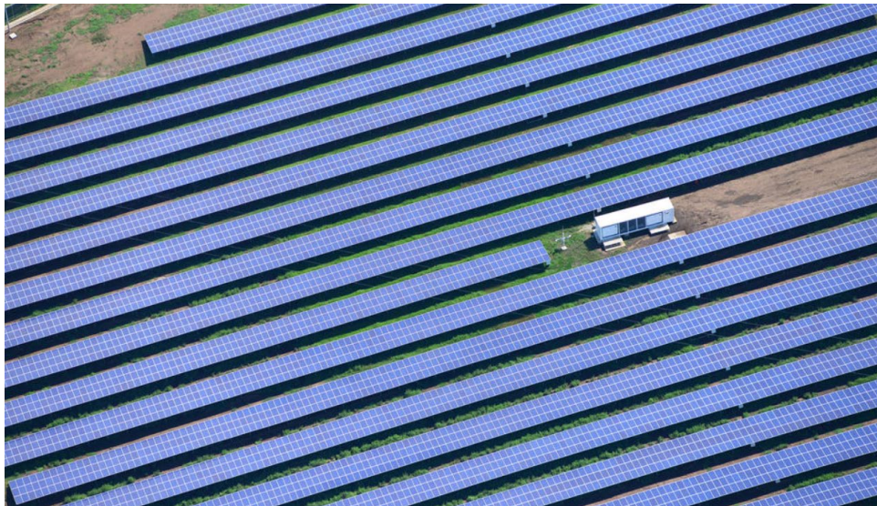
Ilustración 11: Planta fotovoltaica terrestre AES Moncagua, San Miguel
