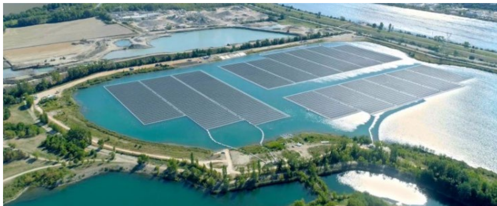
Ilustración 5: Sistema Solar Fotovoltaico flotante O'MEGA 1.
