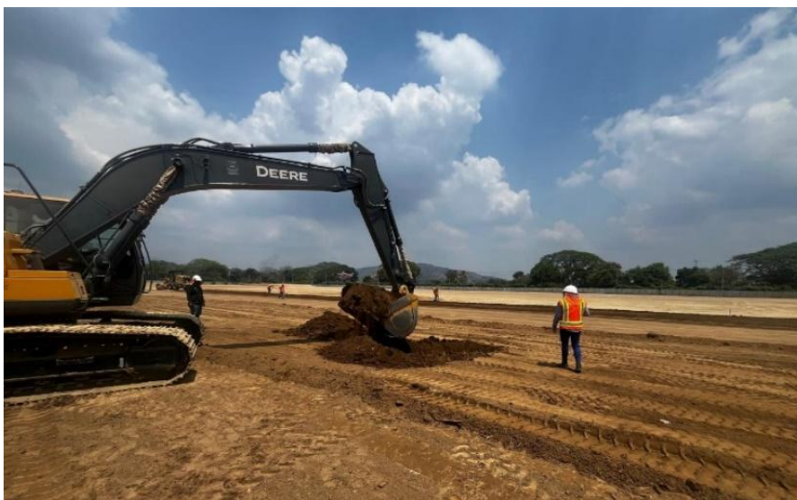
Figura 4. Actividad de Excavación en Terracería
