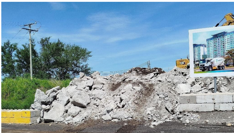
Figura 10. Residuos de Demolición en Planta CDM de Holcim
