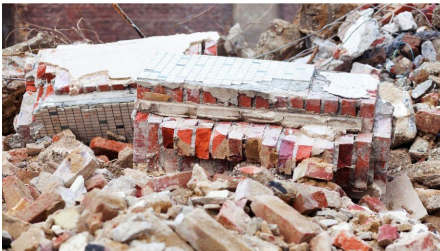
Figura 6. Acopio de Material de Demolición
