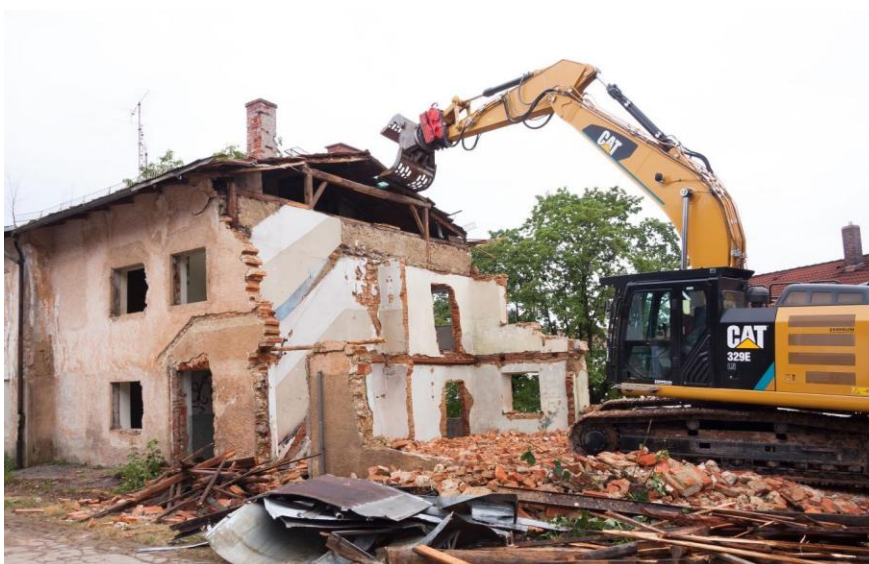
Figura 1. Demolición de Casa Habitacional
