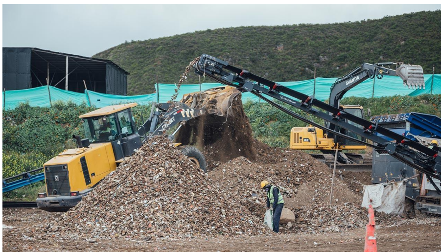
Figura 23. Planta de acopio de RCD, soluciones integrales en Colombia
