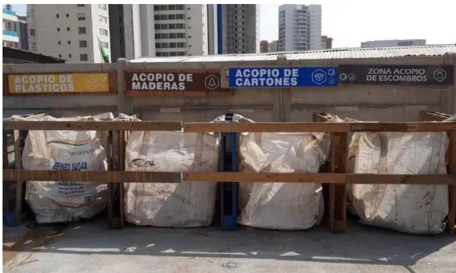
Figura 25. Ejemplo de separación de desechos RCD en obra
