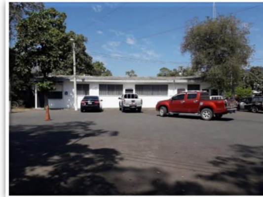
FOTOGRAFÍA N° 26 Dpto. Ingeniería Municipal
