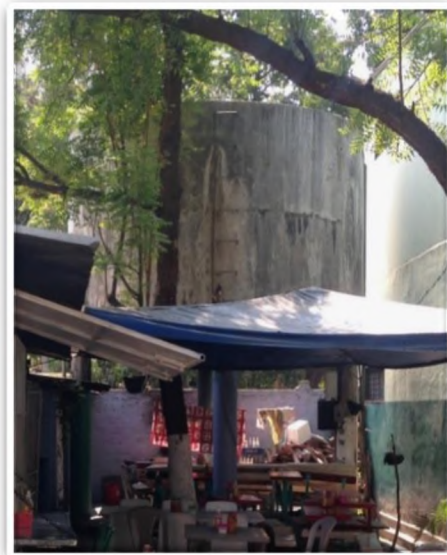
FOTOGRAFÍA N° 10 Tanque de Agua
