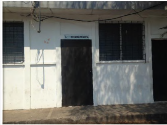
FOTOGRAFÍA N° 25 Dpto. Ingeniería Municipal
