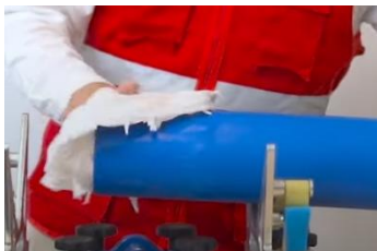
Paso 4: Limpieza de la zona rascada con una franela limpia y alcohol
