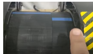
Paso 5: Verificación de que se ha hecho correctamente el frenteado de la tubería
