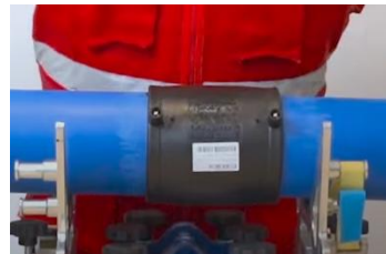
Paso 5: Unión de los dos extremos de las tuberías rascadas con la copla para la electrofusión
