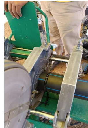
Aplicación de presión en la tubería para que
