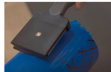
Paso 3: Rascado de zona de unión de la tubería con rascador
