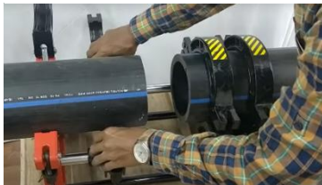
Paso 1: Alineación de los extremos de la tubería a unir
