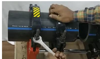
Paso 2: Fijación de las tuberías a unir
