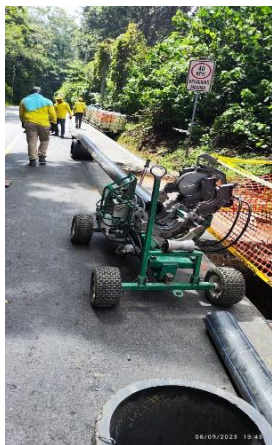
Alineación de la tubería
