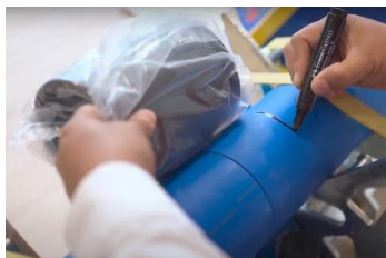
Paso 1: Marcar longitud mínima de acuerdo a la copla a unir a la tubería
