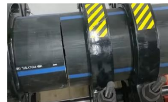
Paso 3: Alineación de tuberías a unir
