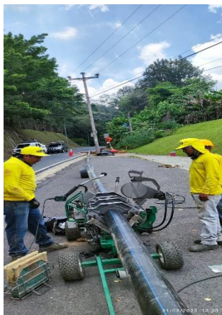
Calentamiento de tubería de PEAD
