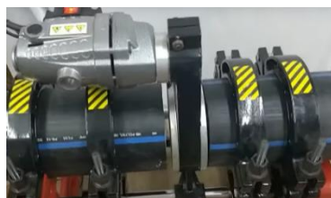
Paso 4: Fronteado de los extremos de la tubería para dar un acabado liso y recto
