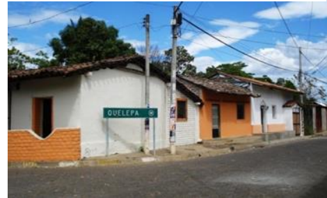
Fotografía 14. Cables de Telefonía
