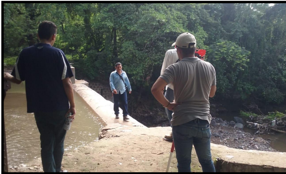
Vista oriente de la presa de la luz
