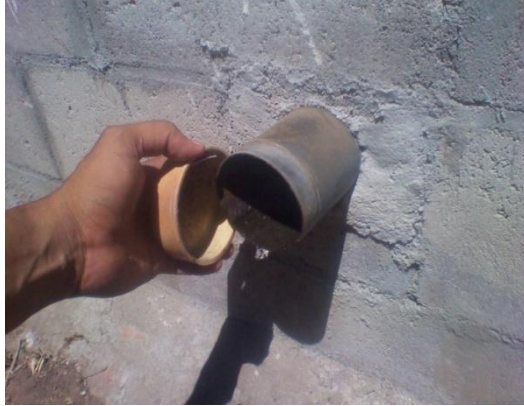
Figura 11. Deposición de agua sucia
