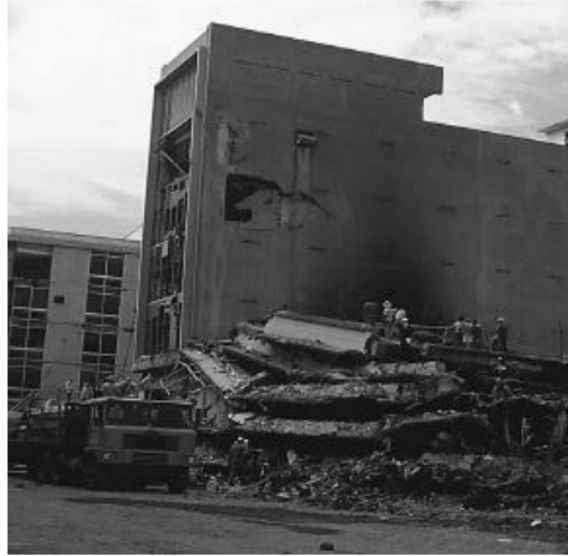
Figura 3.6: Colapso del edificio Rubén Darío después del terremoto de 1986. Extraído de Bommer (1996).
