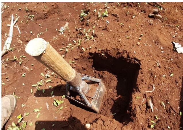
Figura 6. Punto de excavación.
