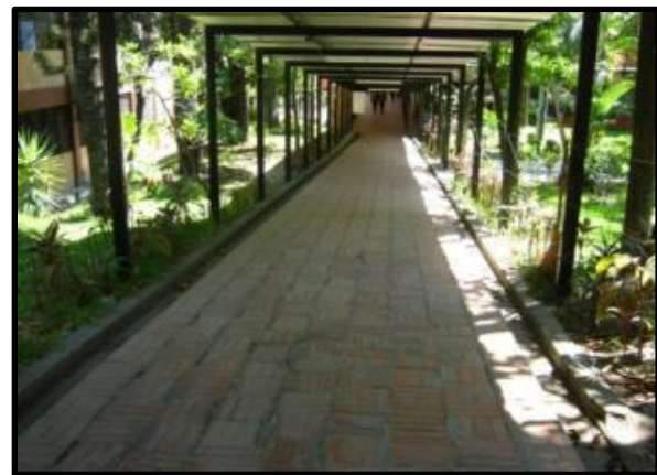
IMAGEN No. 65 ACCESO A EDIFICIO DE MATEMÁTICA DESDE BIOLOGÍA
