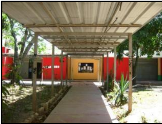
IMAGEN No. 62 ACCESO A AUDITÓRIUM
