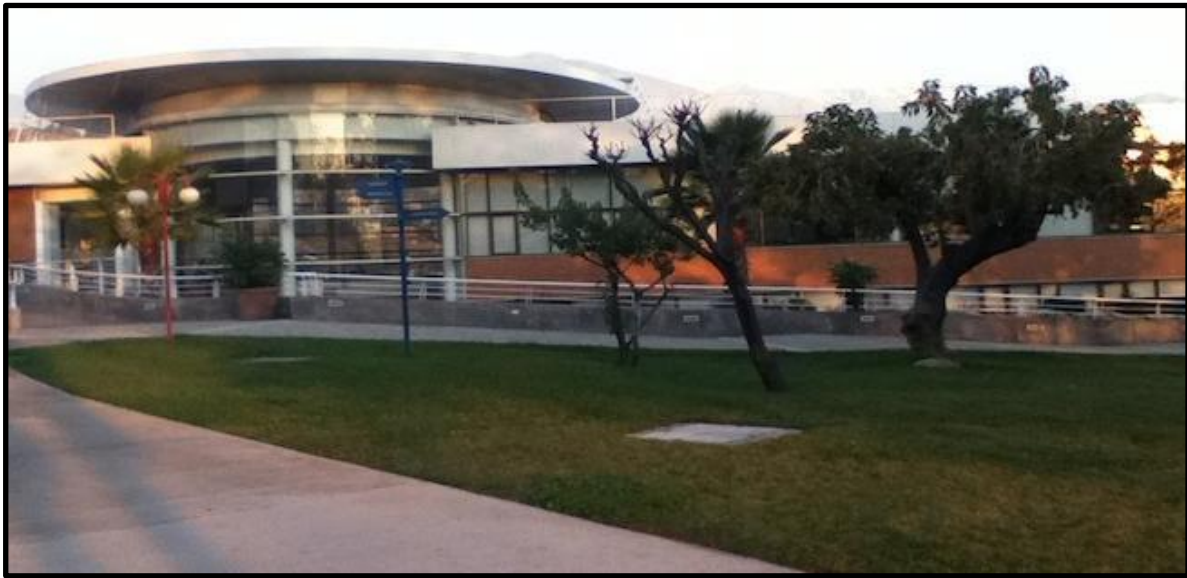
IMAGEN No. 69 FACHADA PRINCIPAL EDIFICIO ADMINISTRATIVO
