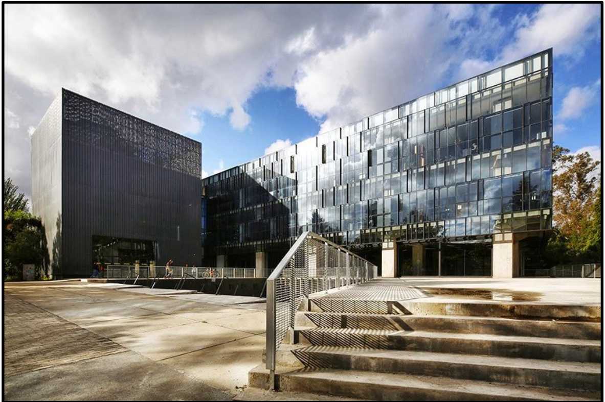
IMAGEN No. 77 FACHADA PRINCIPAL DE EDIFICIO ADMINISTRATIVO
