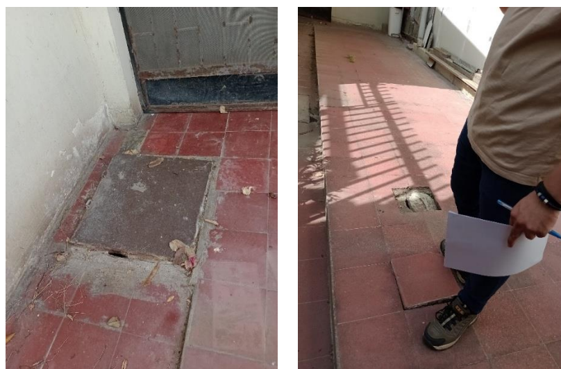
Figura 47. Evidencia de infraestructura piso
