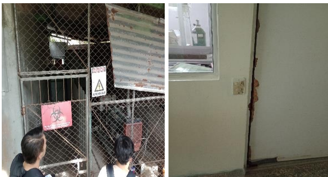
Figura 49. Evidencia para aberturas, cerramientos y ventilación
