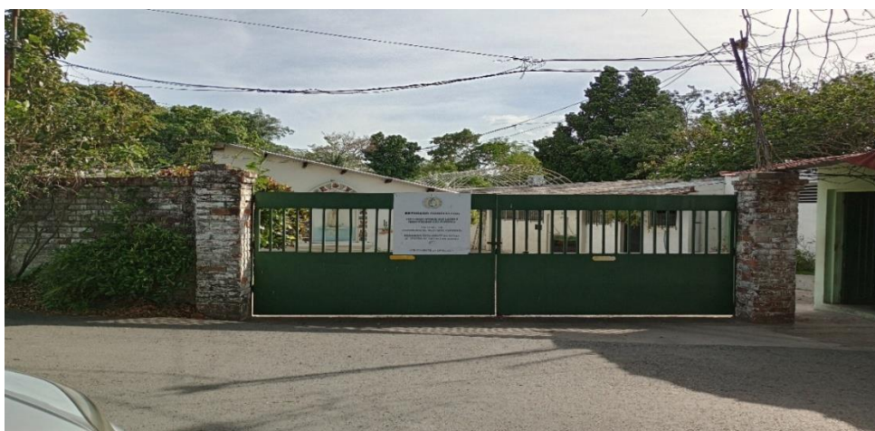
Figura 40. Fachada hospital Divina Providencia
