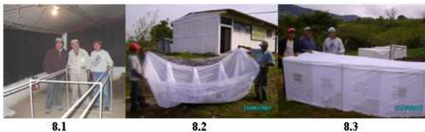
8.1 Armazón de PVC de las jaulas; 8.2 Forro de jaula con cuatro compartimentos; 8.3 Jaulas de infestación completas.
