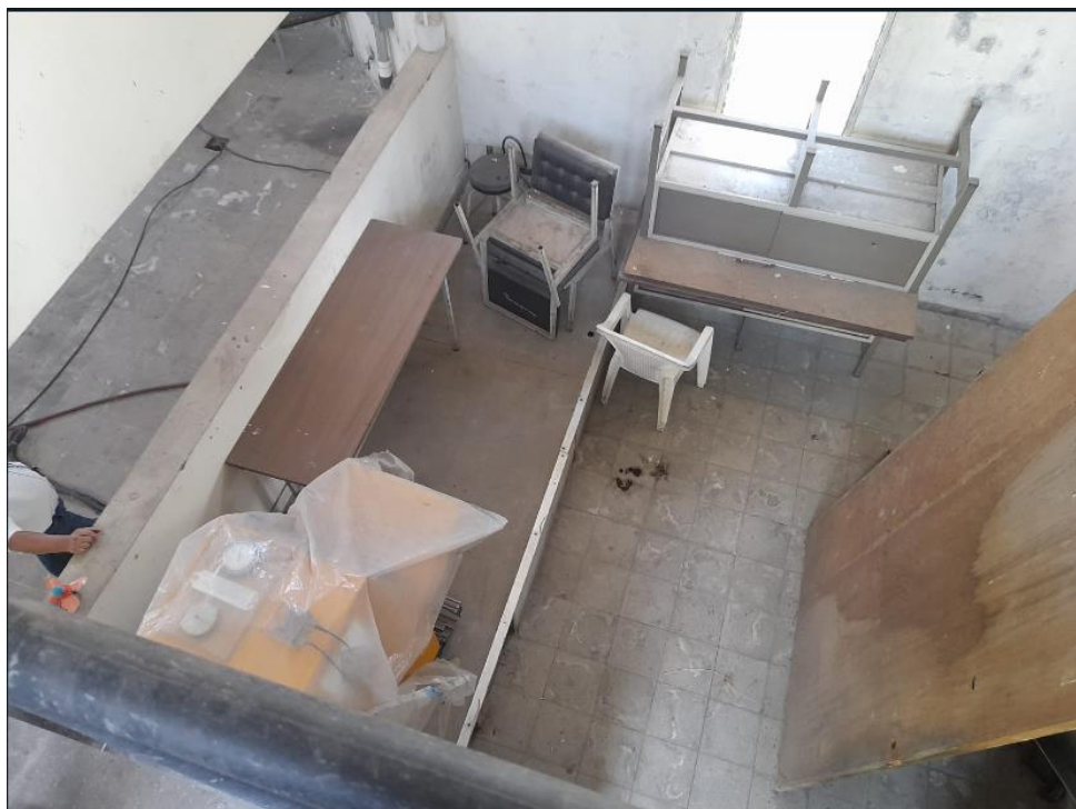
Ilustración 64 Vista desde el segundo nivel de las instalaciones del Laboratorio de Potencia.
