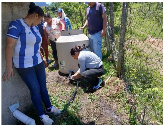
Figura 23 Monitoreo y limpieza de Pozo
