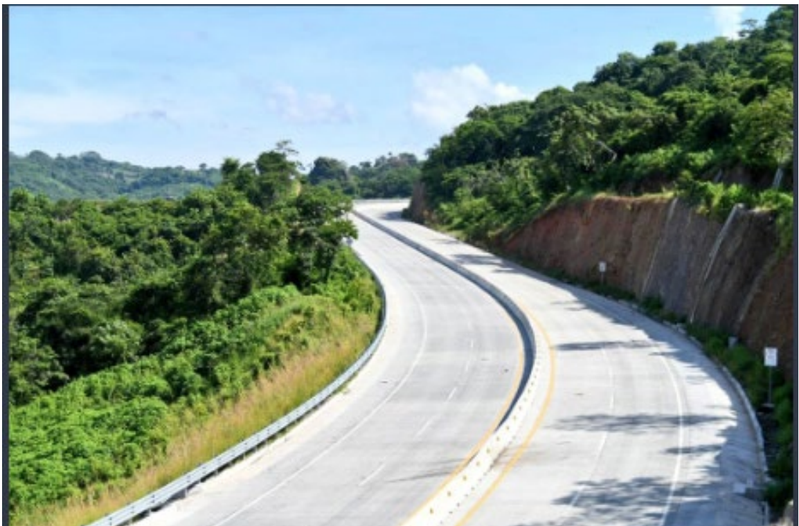
Figura. 3-1 Estado actual Segmento I de la carretera CA04S, tramo III
