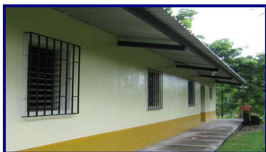
DETALLE DE TECHO, ALEROS DE HIERRO Y ACERA DE CONCRETO
