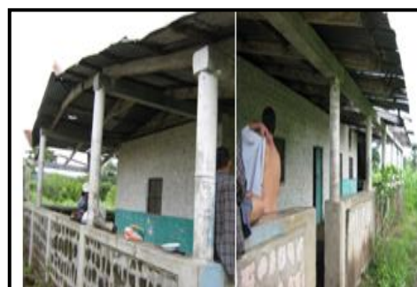
FACHADA SUR Y PONIENTE DE LA CASA
