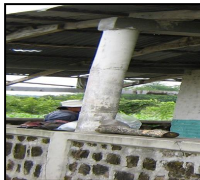
DETALLE DE COLUMNA DE CONCRETO Y MURO DE PIEDRA
