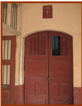
PUERTA DE MADERA CON VENTANAS INCORPORADAS Y ARCO DE MEDIO PUNTO
