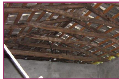
DETALLE DE ESTRUCTURA DEL TECHO DE MADERA
