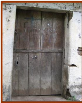
DINTEL Y PUERTA DE MADERA DE DOBLE HOJA
