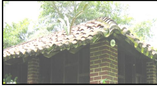
DETALLE DE TECHO DE TEJA ARTESANAL Y VENTANAS CON MALLA CICLON Y MADERA
