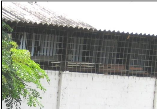
VENTANALES CON REJAS
