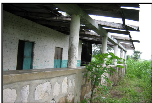
PARTE DE LA ESTRUCTURA DEL TECHO DE LA FACHADA PRINCIPAL
