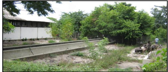
AREA DE BODEGA Y CANALETAS
