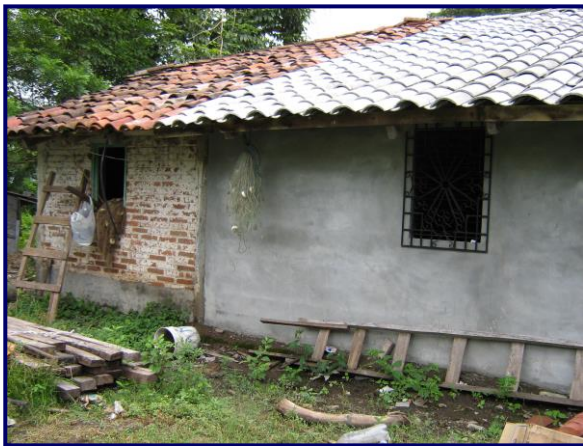
2- Construcción existente de la antigua casa (pared de ladrillo y teja artesanal), construcción nueva, (pared repellada). 3- Estructura del techo de madera, cuenta con energía eléctrica
