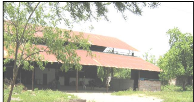
AREA DE RECIBIDERO DE CAFÉ CON DOBLE TECHO DE LAMINA
