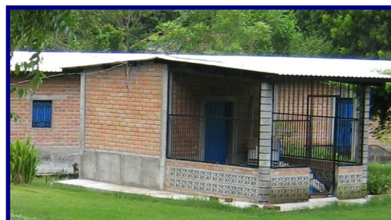
DETALLE DE VENTANAS METALICA CON BALCON DE HIERRO FORJADO DECORADO Y PARED DE LADRILLO DE BARRO VISTO
