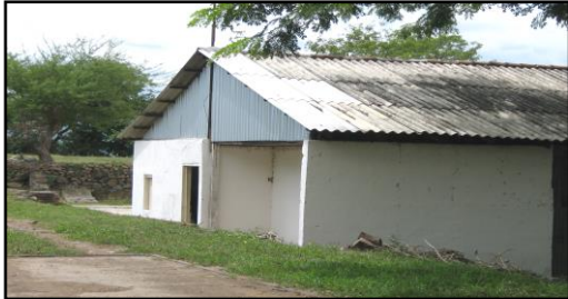
DETALLE DE TECHO DE DURALITA DE LA BODEGA
