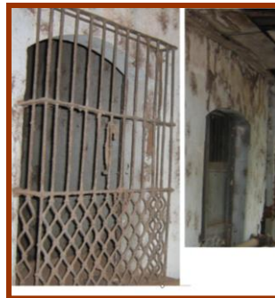
BALCON DE HIERRO FORJADO Y VENTANA CON ARCO DE MEDIO PUNTO
