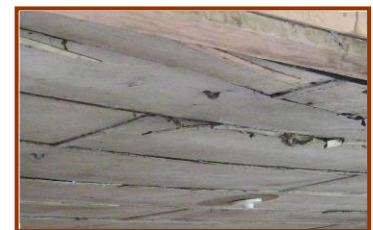
DETALLE DE CIELO FALSO DE MADERA
