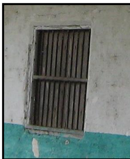
VENTANA DE MADERA CON REGILLAS DE HIERRO
