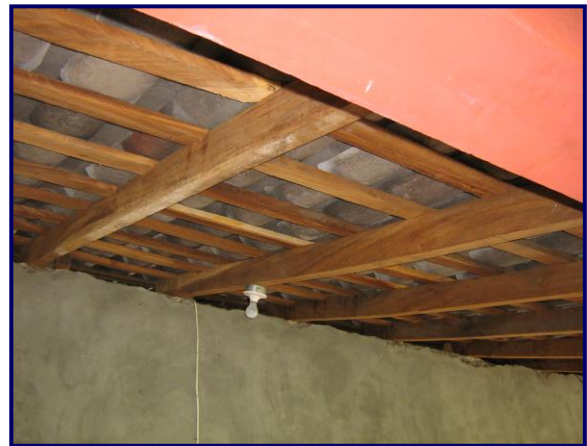
2- Construcción existente de la antigua casa (pared de ladrillo y teja artesanal), construcción nueva, (pared repellada). 3- Estructura del techo de madera, cuenta con energía eléctrica
