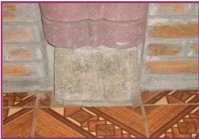
DETALLE DE BASE DE COLUMNA DE CONCRETO Y DE PISO CERAMICA
