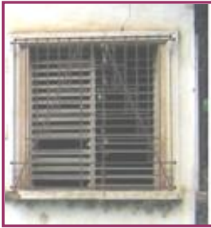
VENTANA SOLAIRE CON BALCON DE HIERRO Y REPISA
