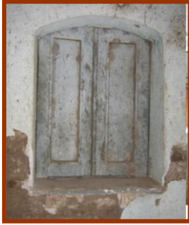
VENTANA DE MADERA CON ARCO DE MEDIO PUNTO
