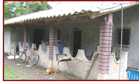
DETALLE DE COLUMNAS Y VERJA DE LADRILLO VISTO VISTO
