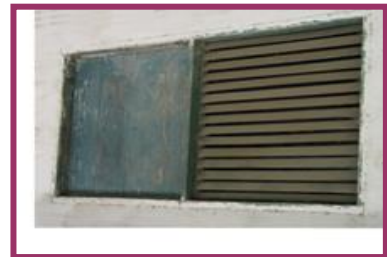
VENTANA DE DOS CUERPOS UNO DE MADERA Y EL OTRO TIPO SOLAIRE CON MARCO DE MADERA
