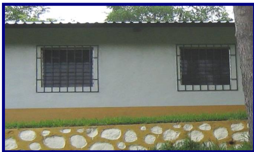
DETALLE DE VENTANAS Y MURO DE PIEDRA PINTADO
