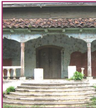
DETALLE DE COLUMNAS, TECHO GRADAS CANECILLOS
