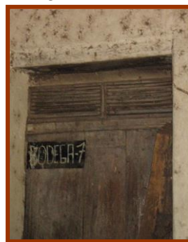
PUERTA DE MADERA DE DOBLE HOJA Y VENTANA CON REJILLAS DE HIERRO
