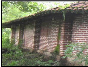
PARED Y COLUMNAS DE LADRILLO PINTADO EN COLOR ROJO
