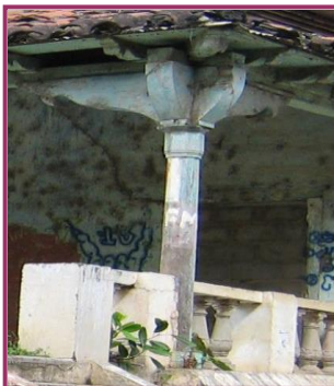
COLUMNA DE CONCRETO
