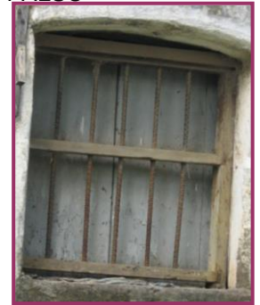
VENTANA DE MADERA CON ARCO DE MEDIO PUNTO Y REJILLAS DE HIERRO
