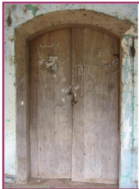
PUERTA DE MADERA DE DOBLE HOJA Y ARCO REBAJADO
