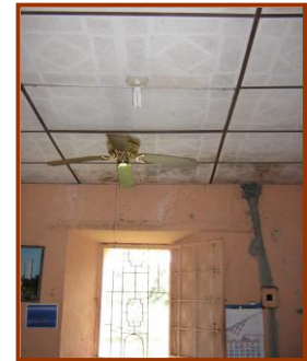
DETALLE DE CIELO FALSO DE ASBESTO Y BALCON DE HIERRO FORJADO
