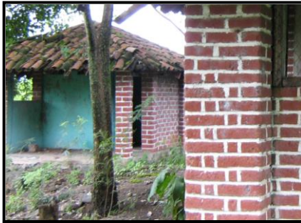
BODEGA CON PARED Y COLUMNA DE LADRILLO
