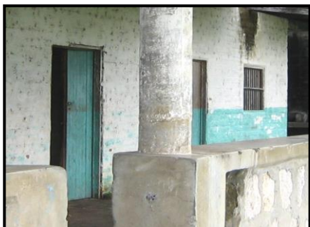
DETALLE DE PUERTA DE MADERA DE DOBLE HOJA CON VANO RECTO EN LA ENTRADA PRINCIPAL DE LA CASA
