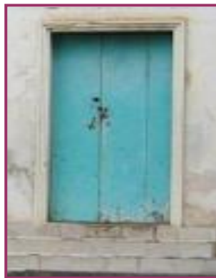
PUERTA DE MADERA GRADAS DE LADRILLO DE CEMENTO
