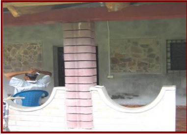
DETALLE DE ENCHAPADO DE PIEDRA EN PARED
