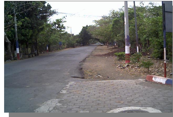
Carretera Los Tubos y Acceso a 4ª Calle Oriente
