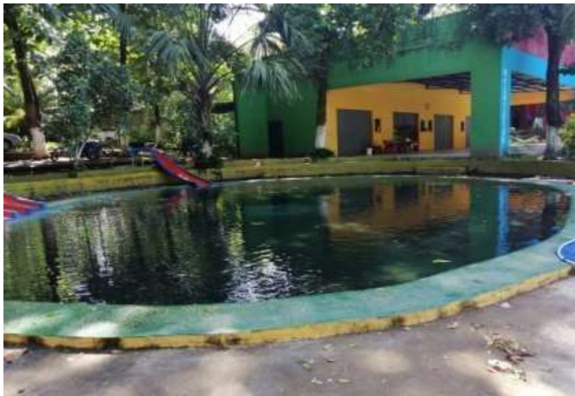
Imagen 41 Vista de estado actual de Piscina Infantil
