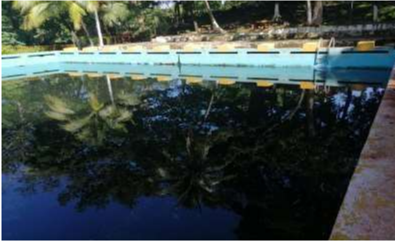
Imagen 44 Estado actual de la piscina olímpica.
