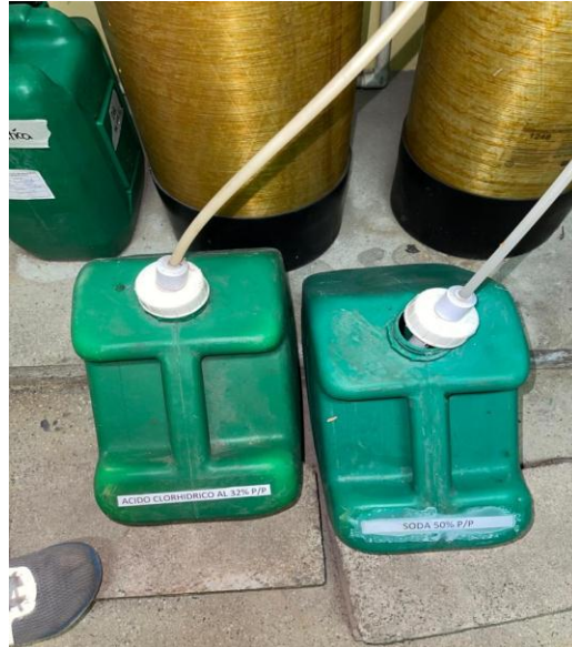
Figura N° 17. Recipientes actuales de ácidos y bases concentradas para regeneración de resinas de intercambio iónico. Fuente: Elaboración propia
