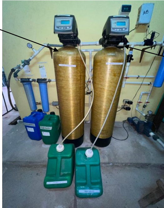
Figura N°20. Filtros de intercambio iónico y catiónico. Fuente: Elaboración propia
