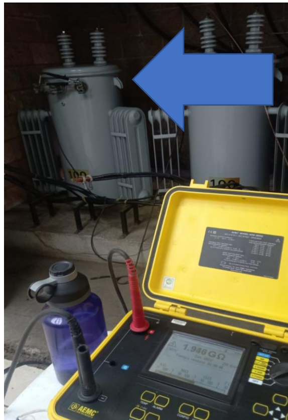
Figura 3.10: Realización de prueba de aislamiento en transformador 4 de 100 kVA
