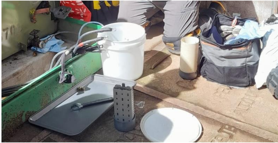
Figura 3.44: Extracción de la muestra de aceite del transformador PAD MOUNTED
