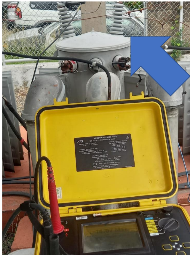
Figura 3.9: Realización de prueba de aislamiento en transformador 3 de 100 kVA
