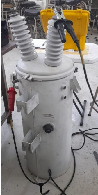
Figura 2.12: Conexión primario a tierra con equipo AEMC 6555
