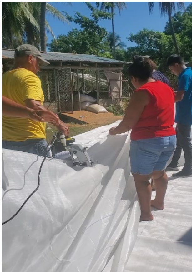
Figura 41, 42 y 43: Se brindó asistencia técnica para la costura de la malla en la construcción de un macro túnel en el cantón Capitán Lazo, Usulután. Esta colaboración garantizó la correcta instalación de la malla, proporcionando un ambiente protegido y óptimo para el cultivo de tomate variedad pony que se sembraría.
