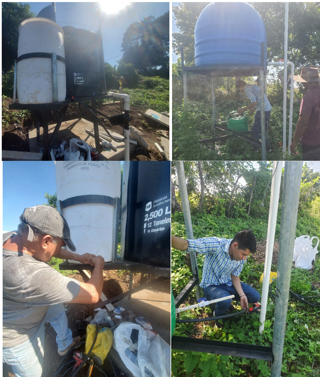
Figura 36, 37, 38 y 40: Se brindó asistencia técnica en la creación de un sistema Venturi casero, ofreciendo orientación desde la selección de materiales hasta la construcción y prueba del dispositivo. Este proceso garantizó la eficiencia y seguridad del sistema, asegurando su funcionamiento óptimo para su propósito previsto.
