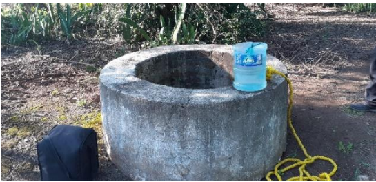
a) Pozo excavado
