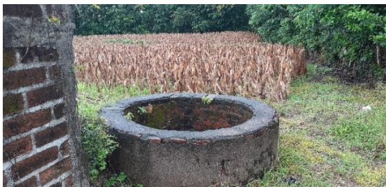
a) Pozo excavado
