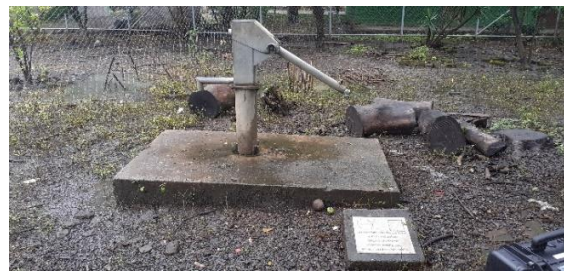
b) Pozo perforado
