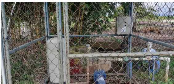
c) Pozo excavado con bomba adaptada
