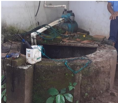
c) Pozo excavado con bomba adaptada
