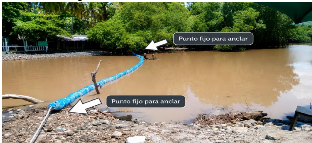
Figura 20. Estructura de ríobarda instalada.
