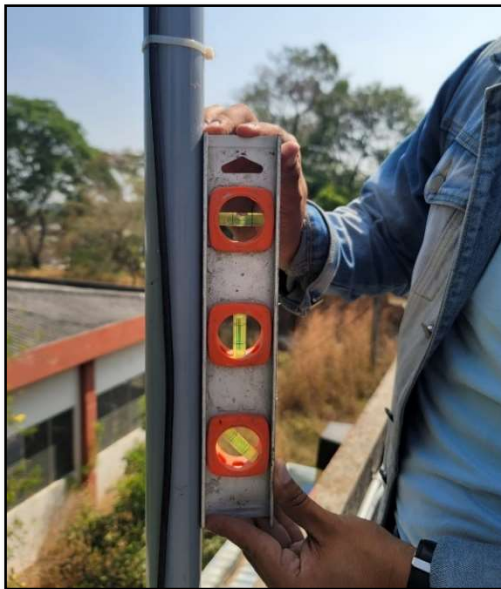
Figura 0.2 Estructura de acero nivelada.
