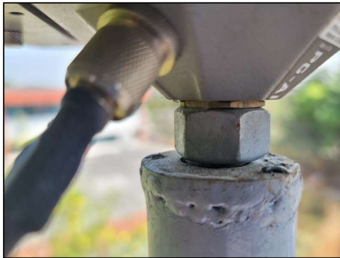
Figura 0.5 Antena nivelada y enroscada sobre estructura de acero.
