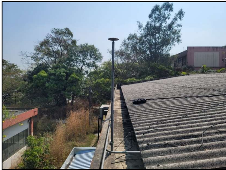
Figura 0.1 Antena sobre el alero en la parte central de la escuela de Ingeniería Civil.
