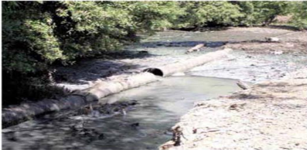
Descarga de aguas residuales domesticas en Puerto el Triunfo, Usulután. Marzo de 2004.
