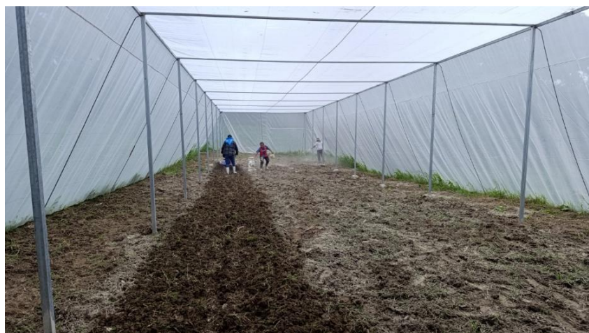
Figura 23. Preparación del suelo en casa malla de la comunidad Hacienda Nueva y aplicación de cal agrícola.
