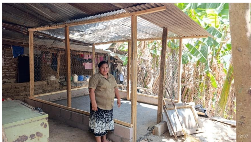
Figura 7. Galpón para crianza de aves construido a productora del cantón Ajuluco.
