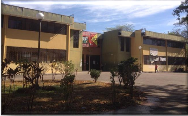
Imagen N° 34 Edificio de la Biblioteca
