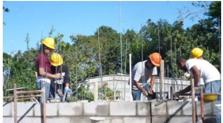
▲ Jóvenes realizan trabajos de construcción de viviendas en Amatitán.
