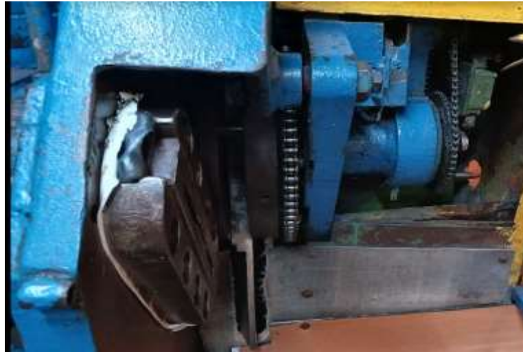
Figura 35. Transmisión mecánica sin medios de protección
