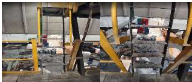
Figura 24:Área de mecanizado de kneader
