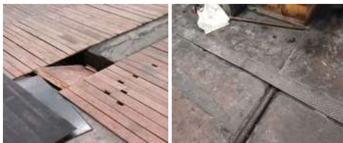
Figura 19: Estado actual de pisos
