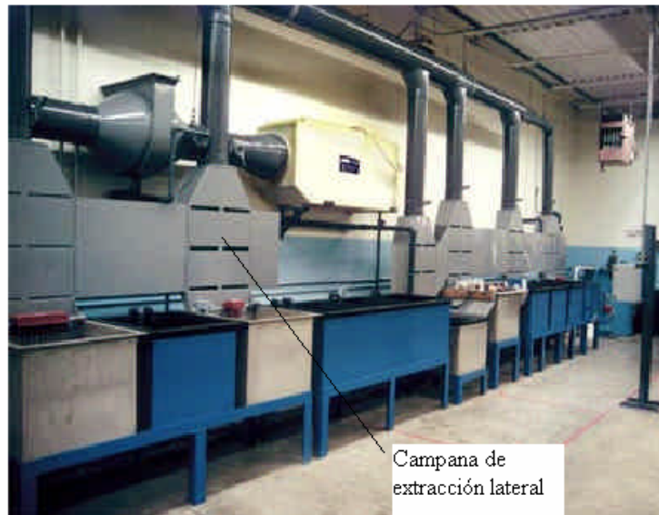
Figura 2.7. Sistema extractor de campana lateral de ranuras.
