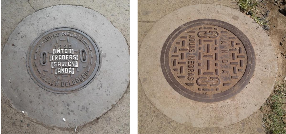
Fotografía 1: Tapadera de pozo de aguas negras frente a parada de buses UNICAES.
