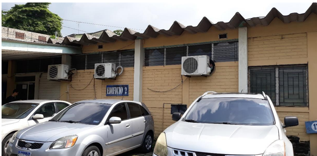
Fotografía 28: Fachada principal del edificio N°2.
