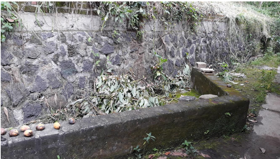
Fotografía 59: Talud ubicado al costado Norponiente del edificio N°2.
