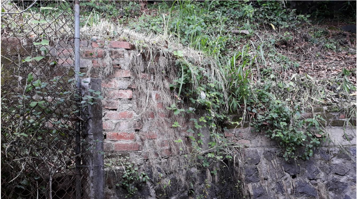
Fotografía 58: Talud ubicado en la parte posterior de los servicios sanitarios.
