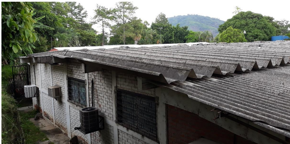
Fotografía 26: Vista noroeste de la cubierta del edificio N°2.
