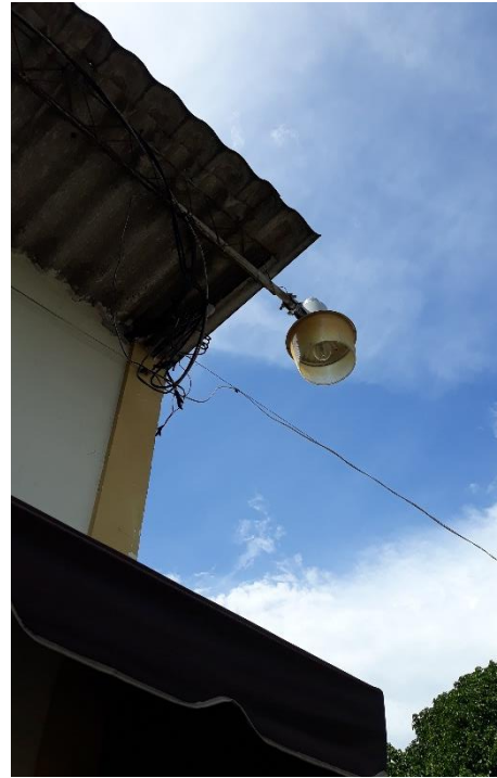
Fotografía 62: Instalaciones eléctricas mal distribuidas entre edificio N°1 y edificio N°3.
