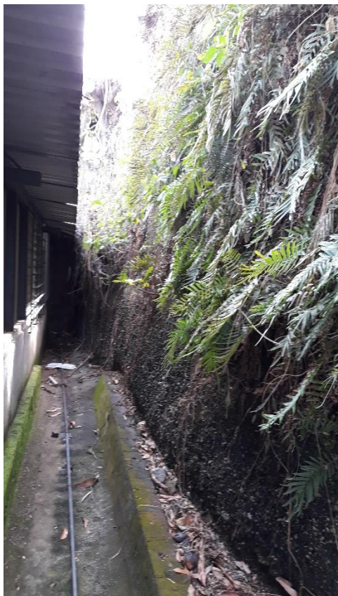
Fotografía 64: Canaleta para aguas lluvias en la parte posterior del edificio N°1.
