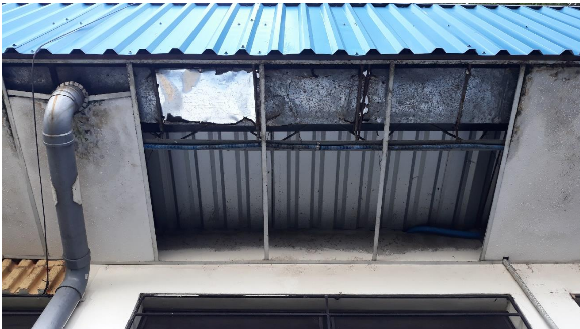
Fotografía 35: Losetas de cielo falso deterioradas en aleros del edificio N°3.
