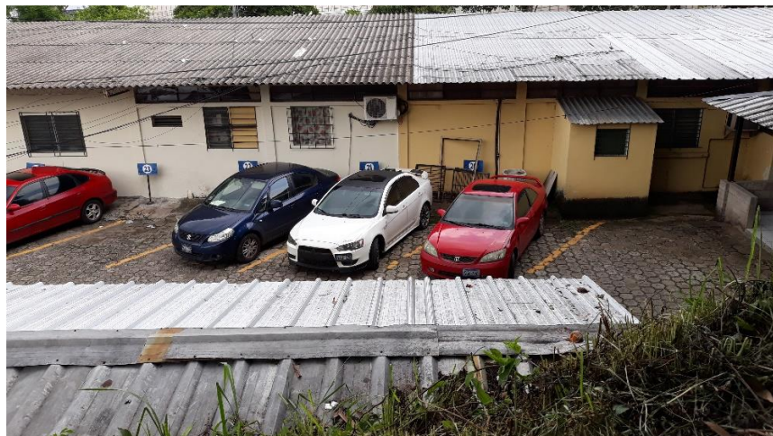
Fotografía 17: Fachada posterior del edificio N°2.
