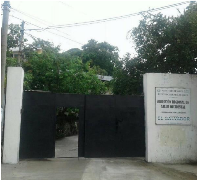
Fotografía 6: Acceso principal sobre calle By Pass.
