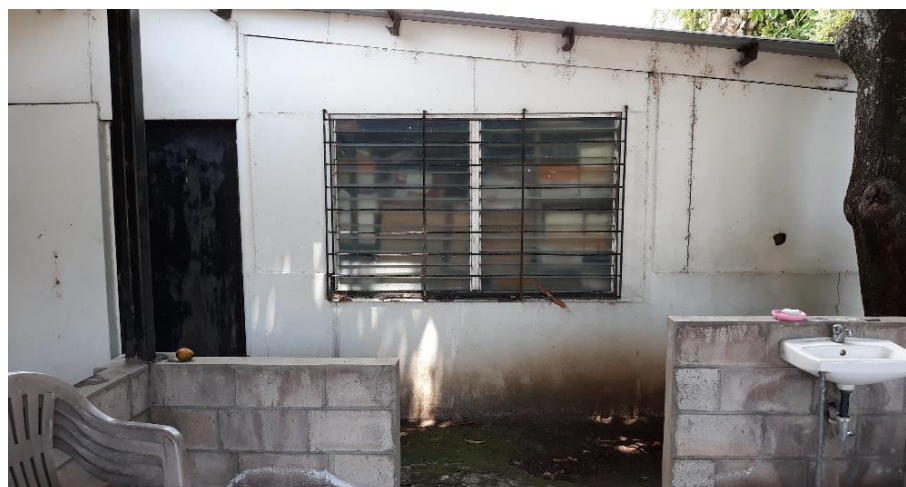
Fotografía 19: Ampliación para bodega del edificio N°2.
