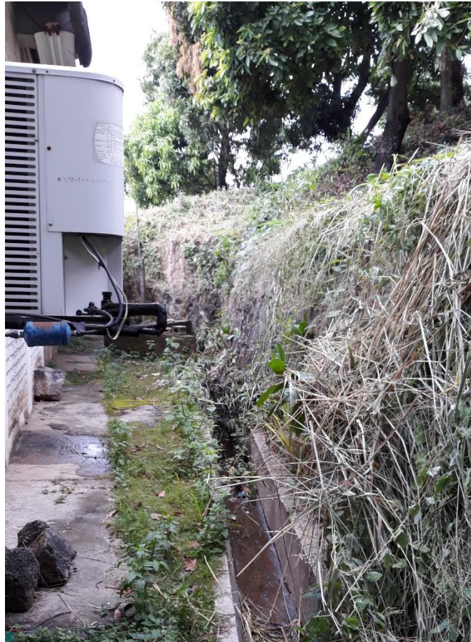
Fotografía 61: Talud ubicado al costado norte del edificio N°2.
