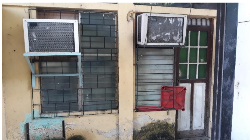
Fotografía 18: Ventanas en fachada posterior del edificio N°2.
