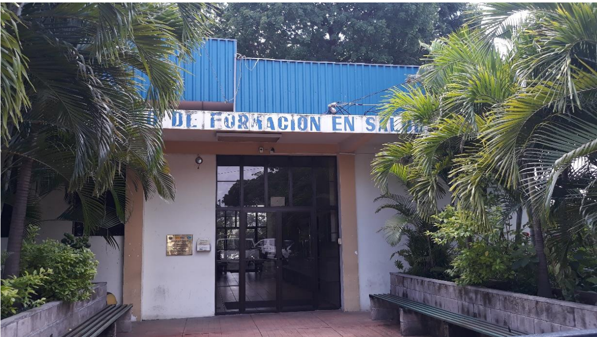
Fotografía 32: Fachada principal del edificio N°3.
