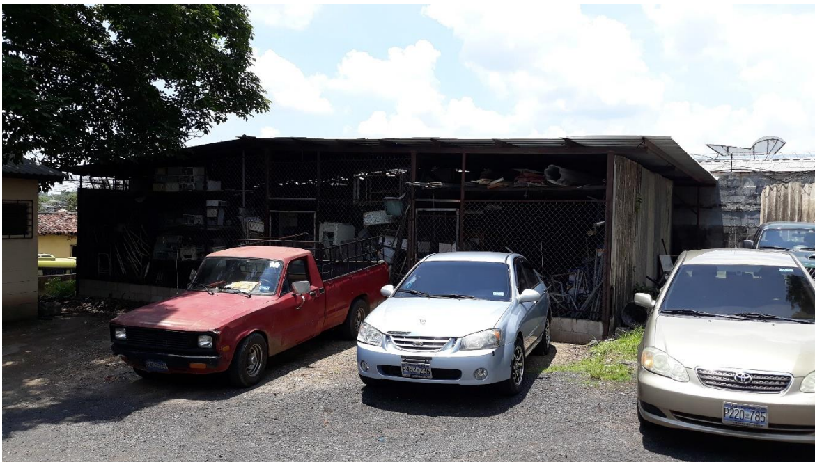
Fotografía 48: Bodega general de equipos y mobiliario dañado.
