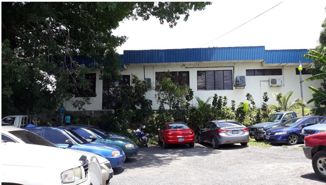
Fotografía 33: Fachada posterior del edificio N°3.
