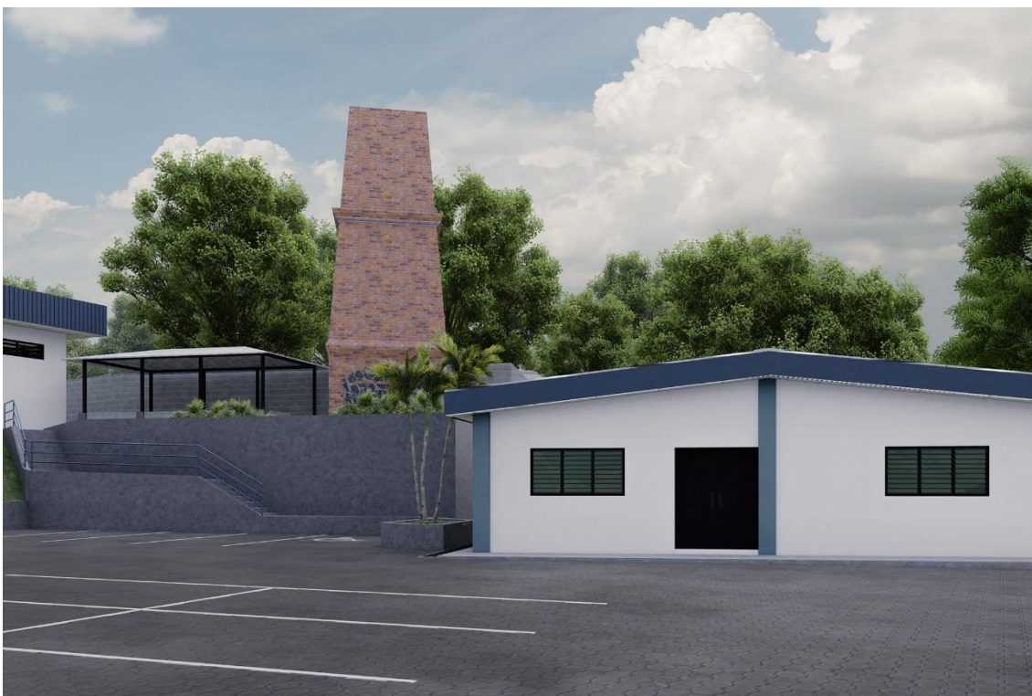
Ilustración 12: Parqueo N°2 y Edificio N°4 fachada sur.
