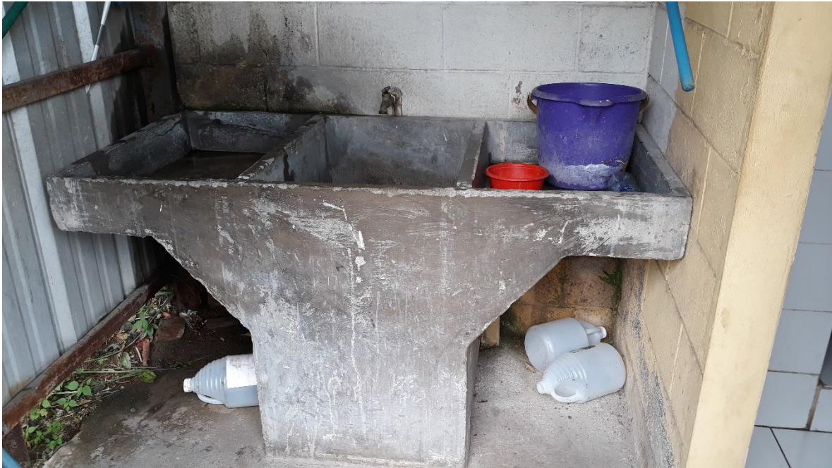
Fotografía 51: Área de lavadero.
