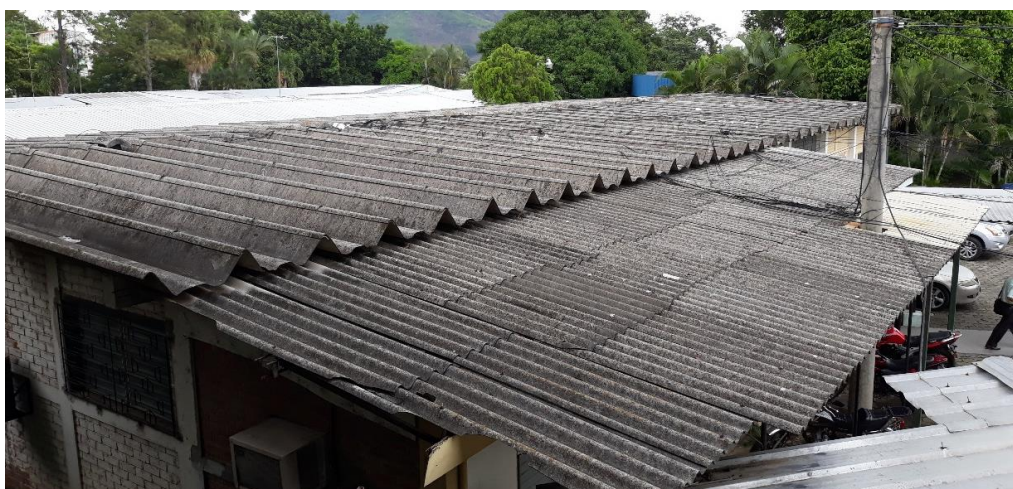
Fotografía 27: Vista oeste de la cubierta del edificio N°2
