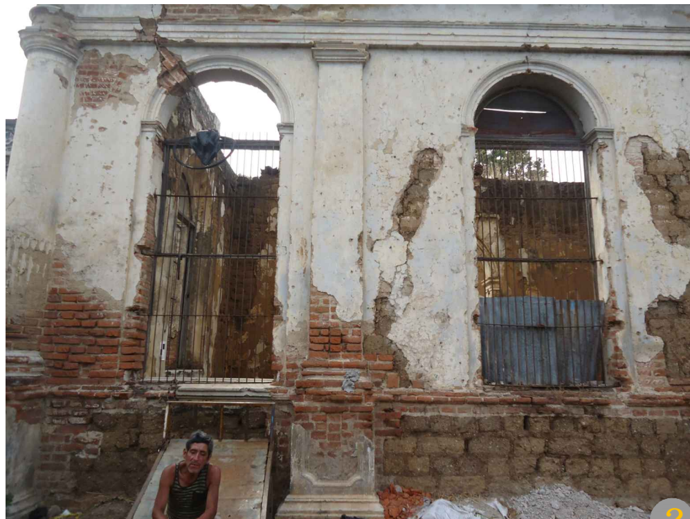
Saliente de la fachada oeste, se observan muy deteriorada, con desprendimientos de repello, y flatantes en sus ventanas.
