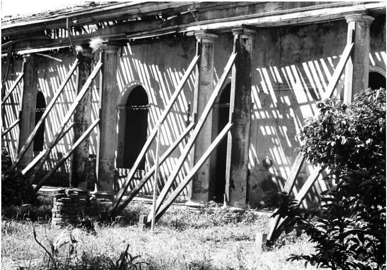
Ilustración 34. Escuela José Mariano Méndez, vista interior, Proceso de desmontaje de Techo, 1981. Fuente: Departamento de registro de bienes culturales, Secretaría de la Cultura de la presidencia, San Salvador.
