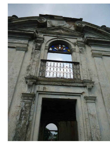
Esc. 1:75 DAÑO PROMEDIO 85% Puerta exterior del tercer nivel, no cuenta con la estructura perimetral, no tiene tableros, solo cuenta con el medio arco de la parte superior, inclusive este elemento presenta daños.
