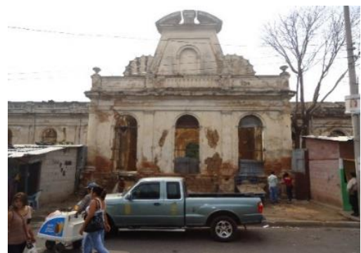
Ilustración 71. Vista de fachada oeste. Fuente: Elaboración Propia.
