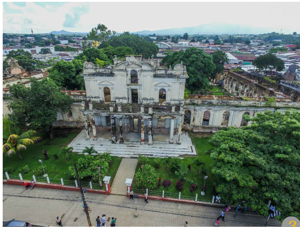
Vista aérea de la fachada norte, se observa el desmontaje total de la estructura de techo, y lámina sobre la estructura de paredes internas, como parte de intervenciones de consolidación.
