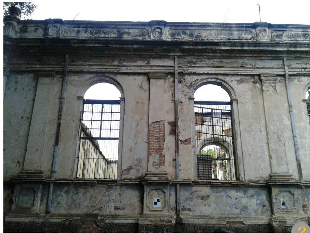
Vista exterior de la fachada norte, se observan bajadas de aguas lluvias de lámina lisa adosadas a la pared, estas se encuentra al costado de las pilastras adosadas.
