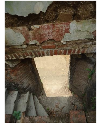
Ilustración 59. Escaleras existentes que conducen al sótano. Fuente: Elaboración propia
