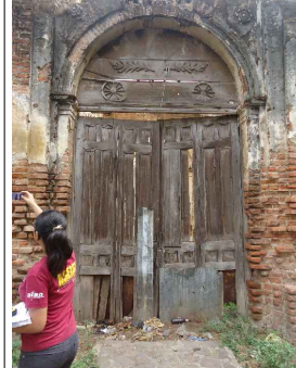
Esc. 1:100 DAÑO PROMEDIO 60% Puerta de acceso en la fachada sur, presenta faltante de tableros, faltante de elementos decorativos y esta desnivelada.
