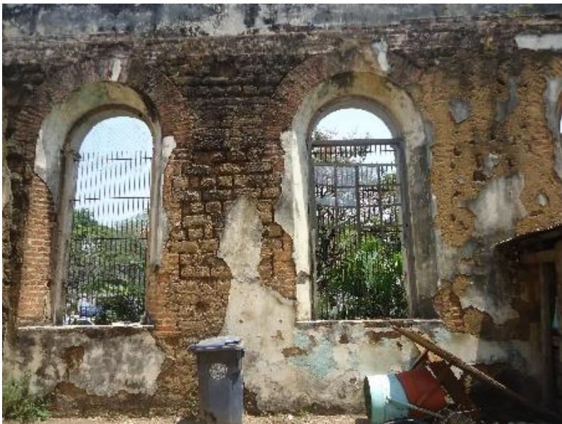
Ilustración 82. Marcos de ventanas de mampostería de ladrillo de barro. Fuente: Elaboración Propia.
