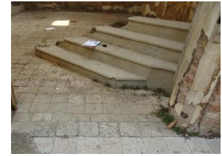
Ilustración 58. Inciso de escalera de caracol en la parte norte. Fuente: Elaboración propia
