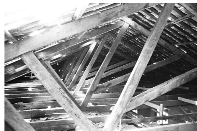
1978 Vista interna de estructura de techo.
