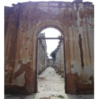
Ilustración 60. Pasillo norte del lado oeste. Fuente: Elaboración propia.
