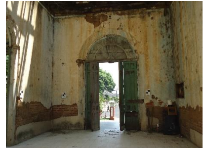
Ilustración 64. Salón de acceso principal. Fuente: Elaboración Propia.
