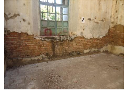
Ilustración 76. Pared mampostería de ladrillo de barro cocido. Fuente: Elaboración Propia.
