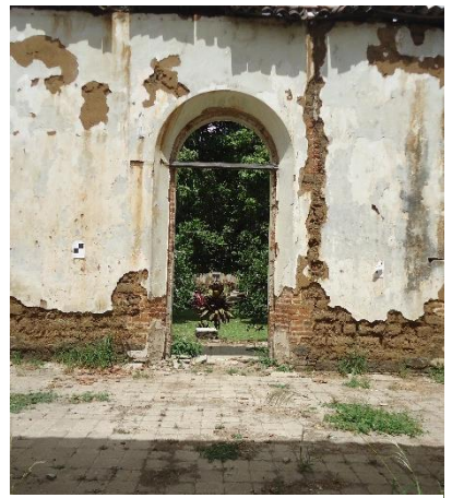
Ilustración 81. Marco de puerta de mampostería de barro. Fuente: Elaboración Propia..
