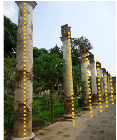
Ilustración 47. Ritmo en Columnas Externas, Fuente: Elaboración Propia.
