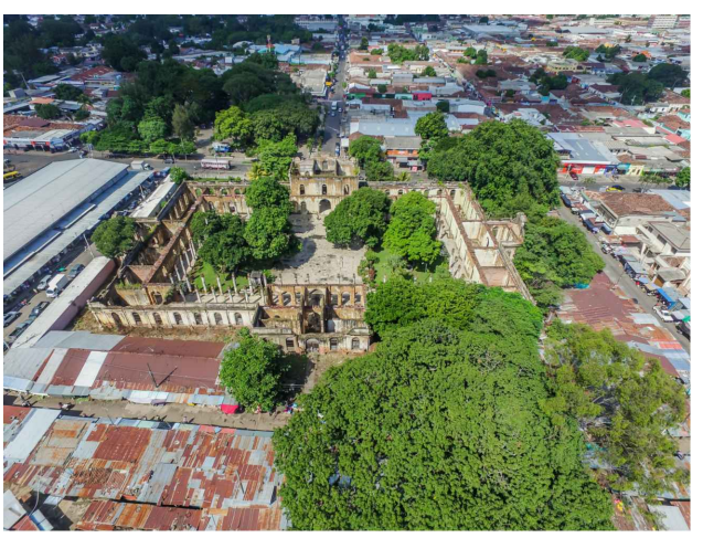
Vista superior fachada Sur. Invasión de ventas.
