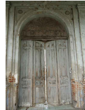
Esc. 1:100 DAÑO PROMEDIO 15% Puerta de acceso principal, conserva la estructura, los tableros, se ha decolorado por el tiempo y esta desnivelada.
