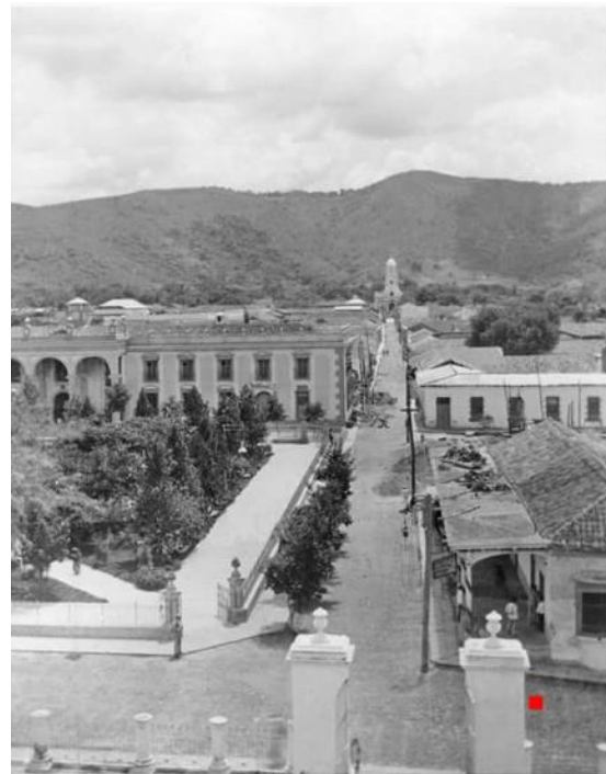
Ilustración 9. Fotografía tomada desde la parroquia central de la ciudad salvadoreña de Santa Ana, de los últimos años de la década de 1890s, donde se observa el palacio municipal, el edificio original del casino santaneco, y el portal Los Bernales. Fuente: Colección de la Egyptian Tobacco Co.
