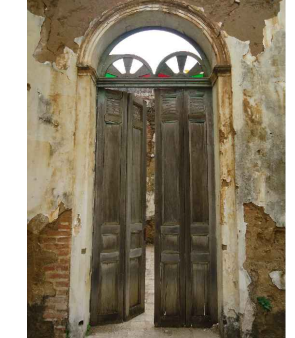
Esc. 1:100 DAÑO PROMEDIO 30% Puerta desnivelada, no cuenta con el decorado de la parte superior, madera en estado de descomposición causado por la humedad.
