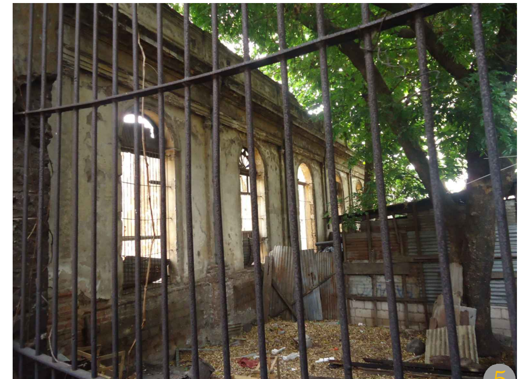
Se observan desprendimientos de repellos, faltantes de ventanas, daños en defensas de ventanas, fisuras y grietas en la estructura de pared.
