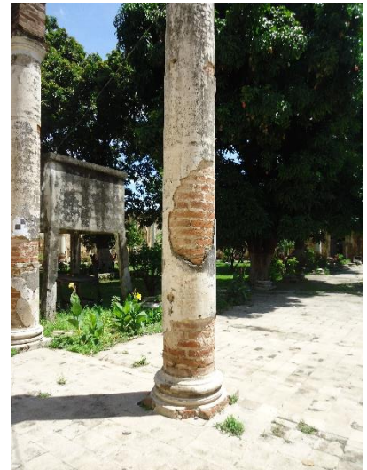
Ilustración 79. Columna de mampostería de ladrillo de barro cocido. Fuente: Elaboración Propia.
