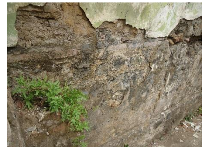
Ilustración 78. Pared de mampostería e piedra. Fuente: Elaboración Propia.
