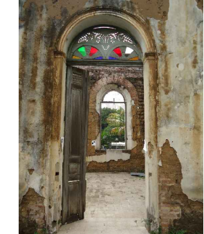
Esc. 1:100 DAÑO PROMEDIO 80% Puerta que aun mantiene la estructura perimetral, pero solo cuenta con un tablero, el cual esta desnivelado.
