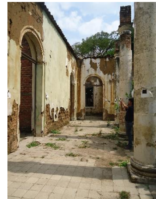
Ilustración 73. Pasillos del lado este. Fuente: Elaboración Propia.
