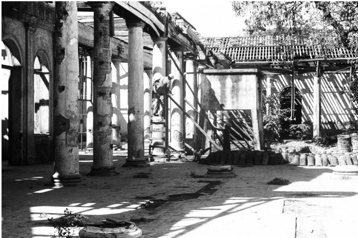
Ilustración 35. Escuela José Mariano Méndez, vista interior, Proceso de desmontaje de Techo, 1981. Fuente: Departamento de registro de bienes culturales, Secretaría de la Cultura de la presidencia, San Salvador.
