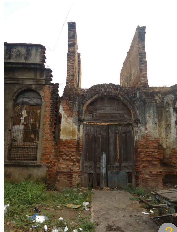
Puerta secundaria y fachada sur completamente deterioradas por parte de los terremotos.
