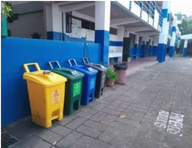
Foto 04: Los baños son funcionales, poco limpios y no cuentan con papel ni jabón, solo con agua para la higiene de las manos. Como también no hay una alguna accesibilidad para necesidades especiales.
