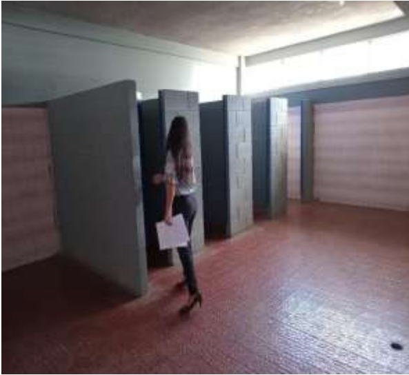
Foto 03: La distribución de basureros no es proporcionada, pues hay basureros solamente en la parte de las oficinas de la dirección.
