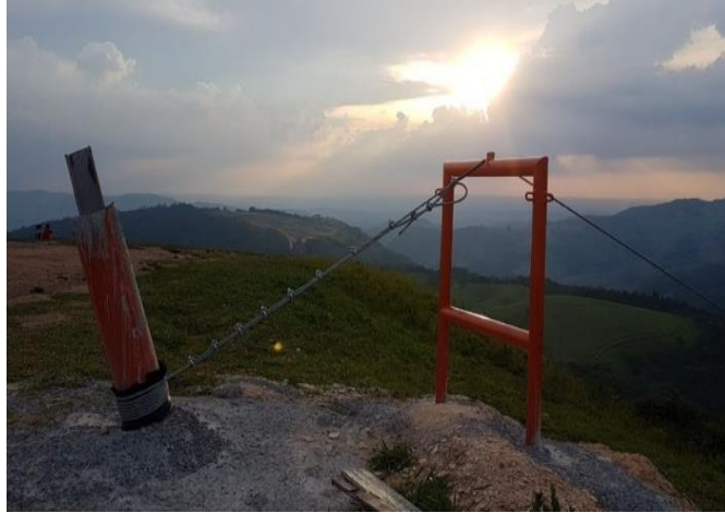
Ilustración 50. Ejemplo de anclaje con vigas H
