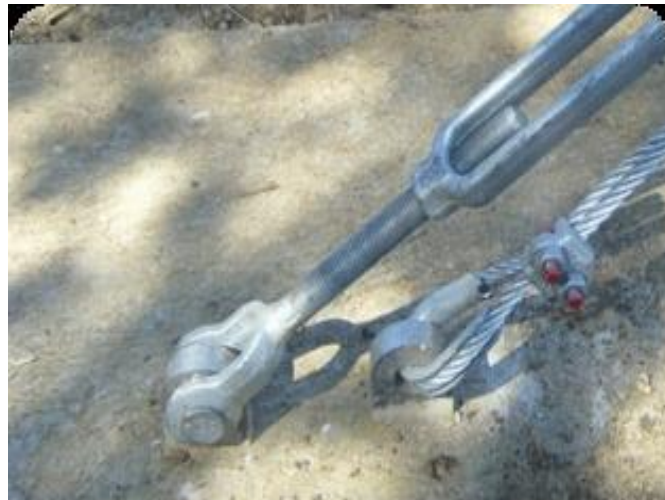
Ilustración 51. Ejemplo de anclaje en plataforma de concreto
