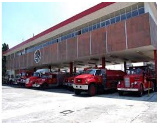
Estación de bomberos central.
