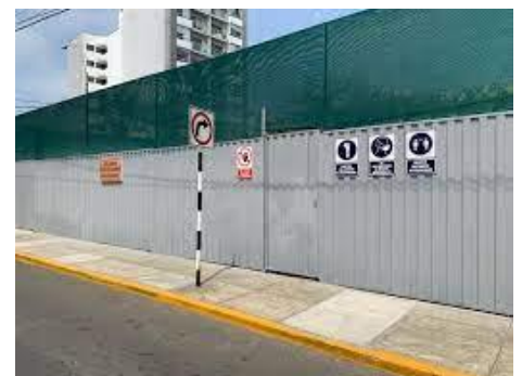
Imagen 26. Cerco perimetral provisional
