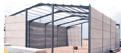
Foto 1. Nave de estructura mixta
