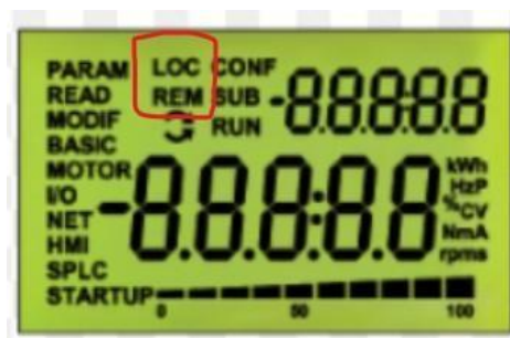
Ilustración 18. HMI de variador de frecuencia.
