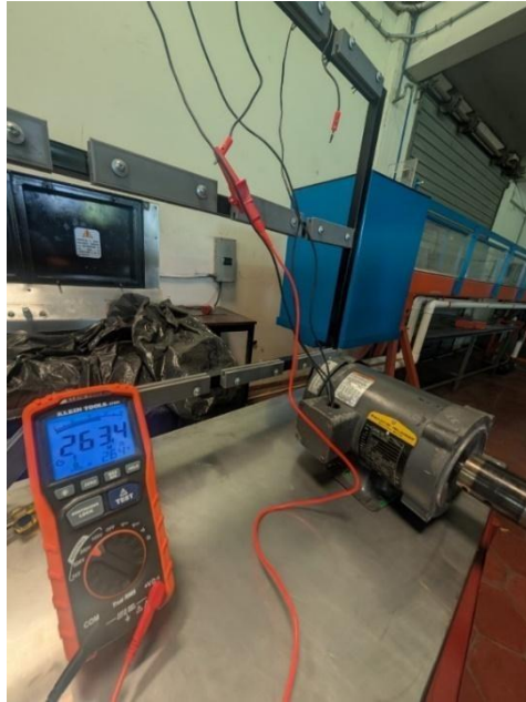
Figura 3.14. Resistencia de fase 1 prueba de CD. Valores en Megaohmios. (Fuente: autores)
