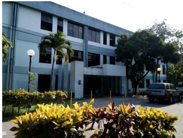
Edificio de Psicología
