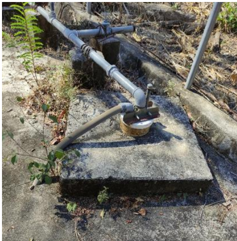
Figura 13. Superficie del pozo (nivel del suelo)
