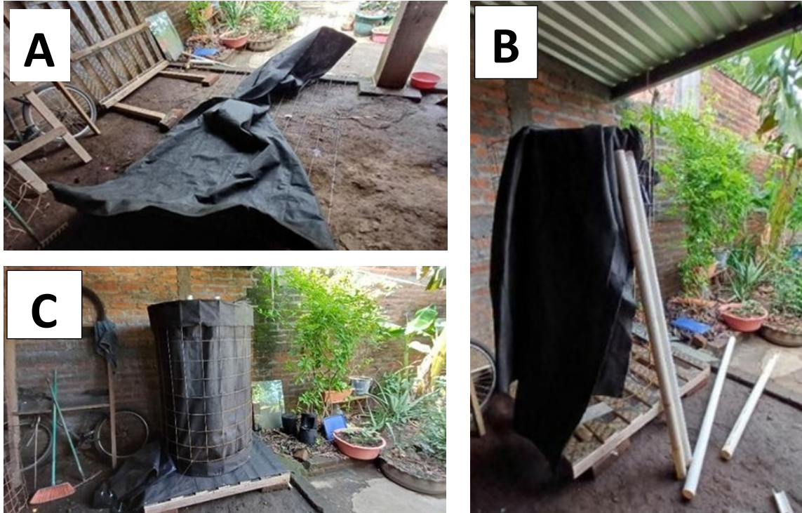
Figuras 7. Proceso de recubrimiento de cilindro biorreactor. A) Toma de medidas de geo textil. B) Materiales previos a su colocación. C) Cilindro recubierto con geotextil.
