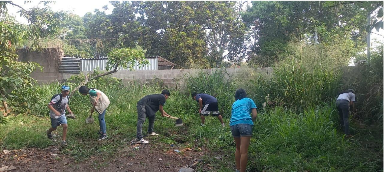
A- 18. Adecuación con jóvenes beneficiarios para instalación de casa malla.
