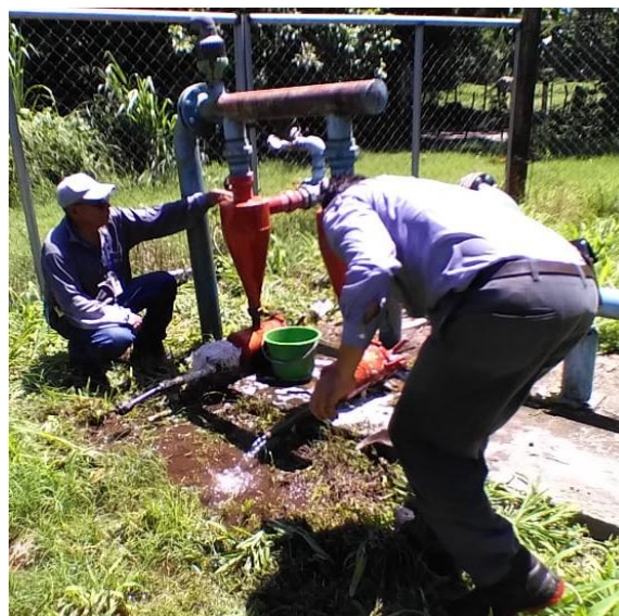
Figura A- 6. Limpieza de tubería y del área
