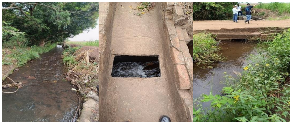
Figura 5. Inspección en Nahulingo, Sonsonate.
