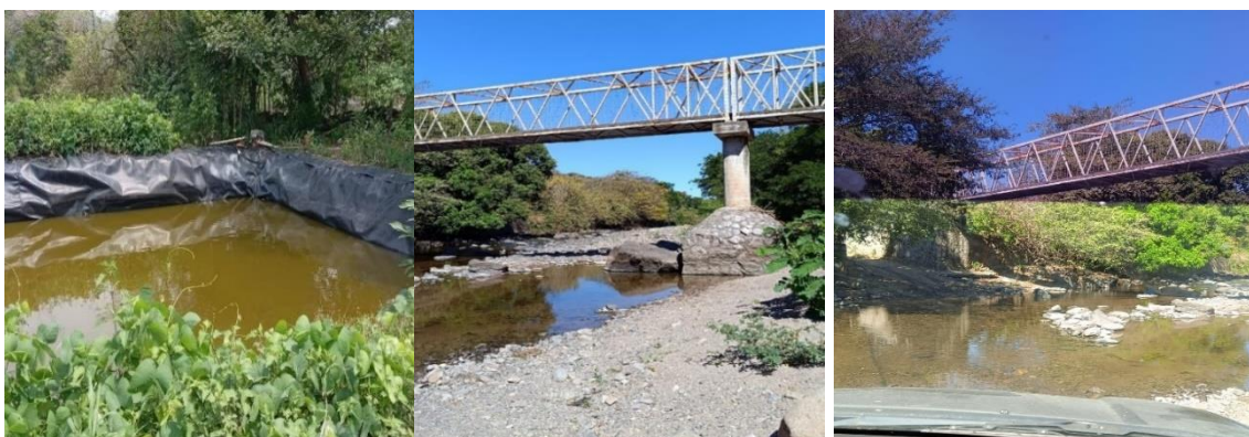
Figura 3. Inspección en Anamorós, La Unión.
