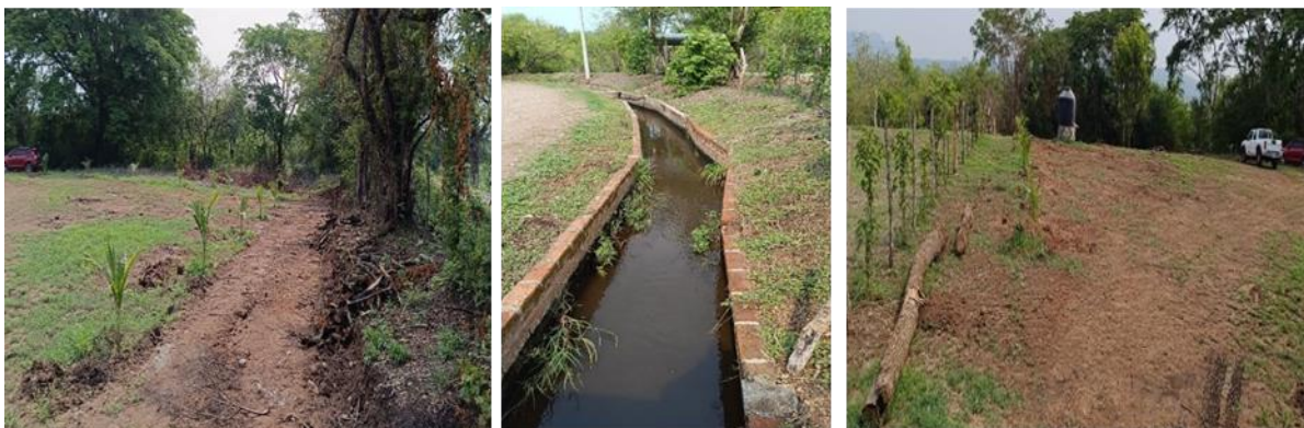
Figura 32. Inspección por segregación en el Distrito de Riego Atiococho Sur.
