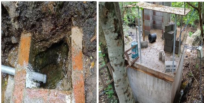
Figura 25. Inspección en Sensuntepeque, Cabañas.
