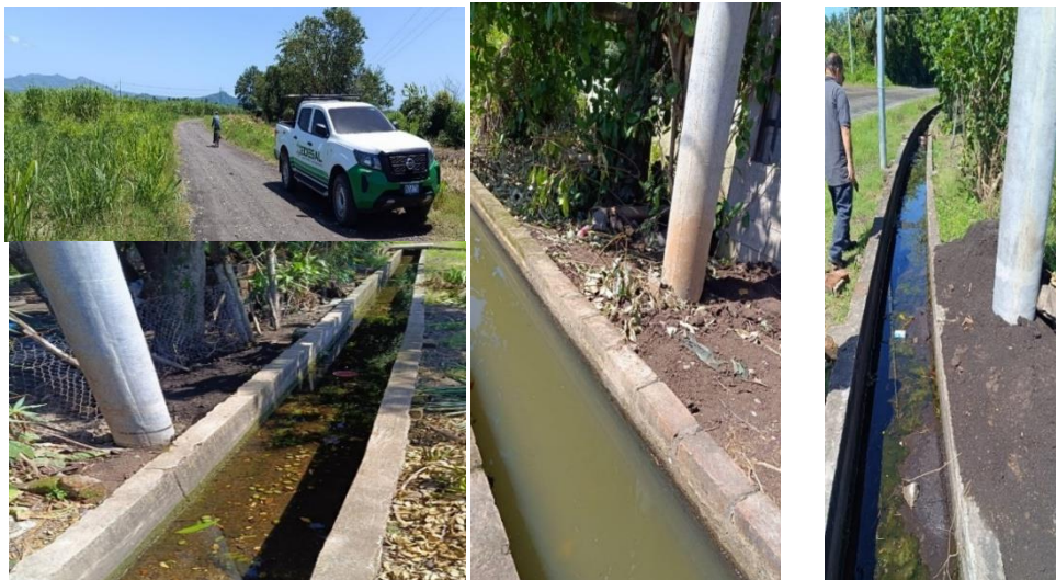
Figura 27. Inspección en el Distrito de Riego de Zapotitán.
