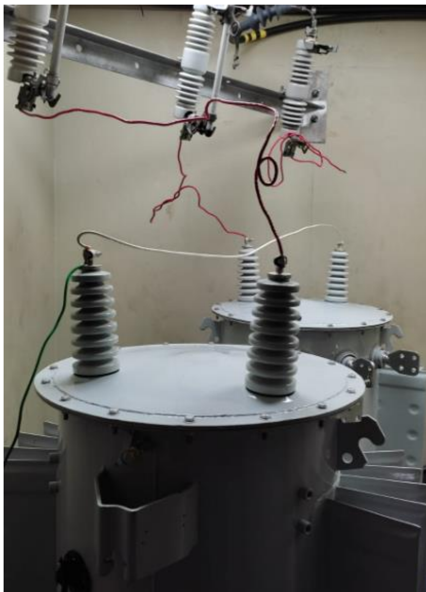
Ilustración 36. Prueba de tensión inducida.
