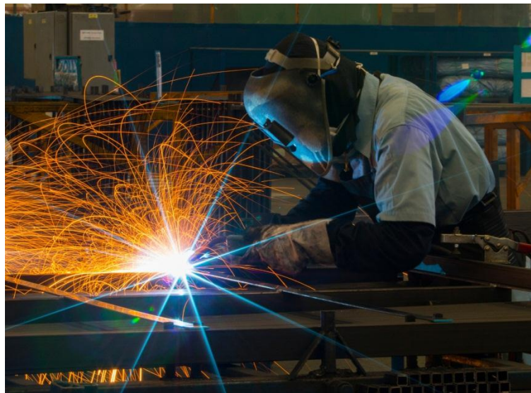
Fig. 2.13. Persona realizando una Soldadura.
