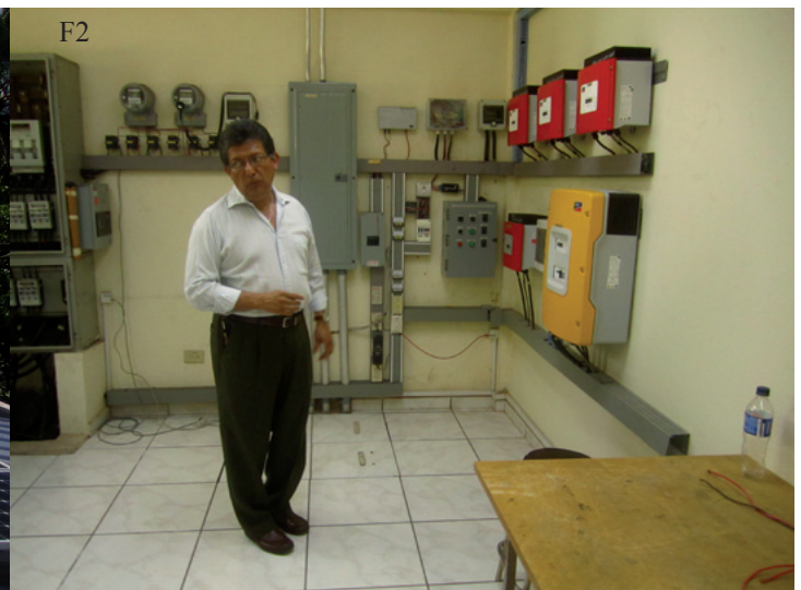
F1. Paneles solares instalados en el techo del edificio de la Escuela de Ingeniería Eléctrica. F2. Inversores de interconexión.
