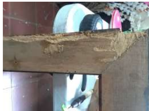
Figura 89. Detalle reconstrucción contramarco obra 1. Fotografía tomada por: Grecia Mejía
