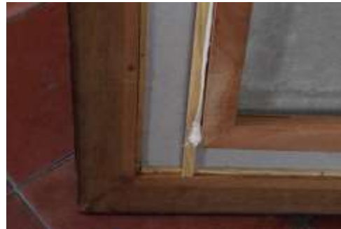
Figura 85. Detalle de contramarco proceso restauración en obra 1. Fotografía tomada por: Valeria Martínez.
