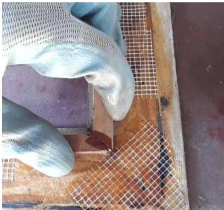
Imagen 50. Detalle de aplicación de fibra de vidrio y resina para la restauración del contramarco de la obra 1. Fotografía tomada por: Carlos Cubías
