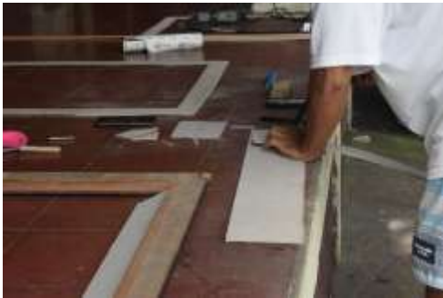
Figura 84. Proceso de restauración de contramarco. Fotografía tomada por: Valeria Martínez.
