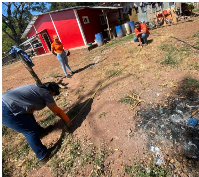
Figura 2. Evaluación de un terreno y medición del área en cantón El Coyalito, Conchagua, La Unión, para construcción de tanques de agua.
